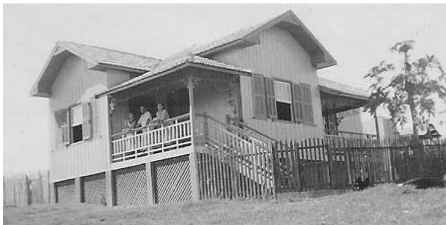
Residência de José de
